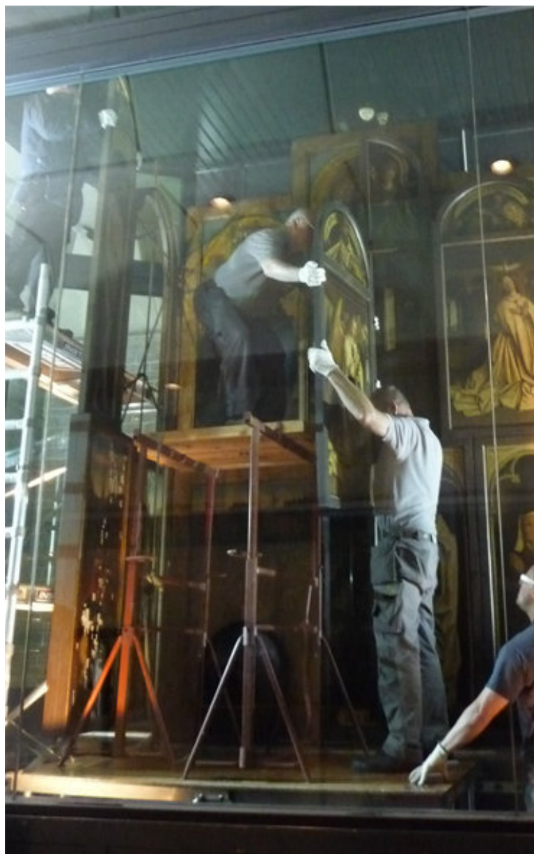
Demontage van de linker kant
